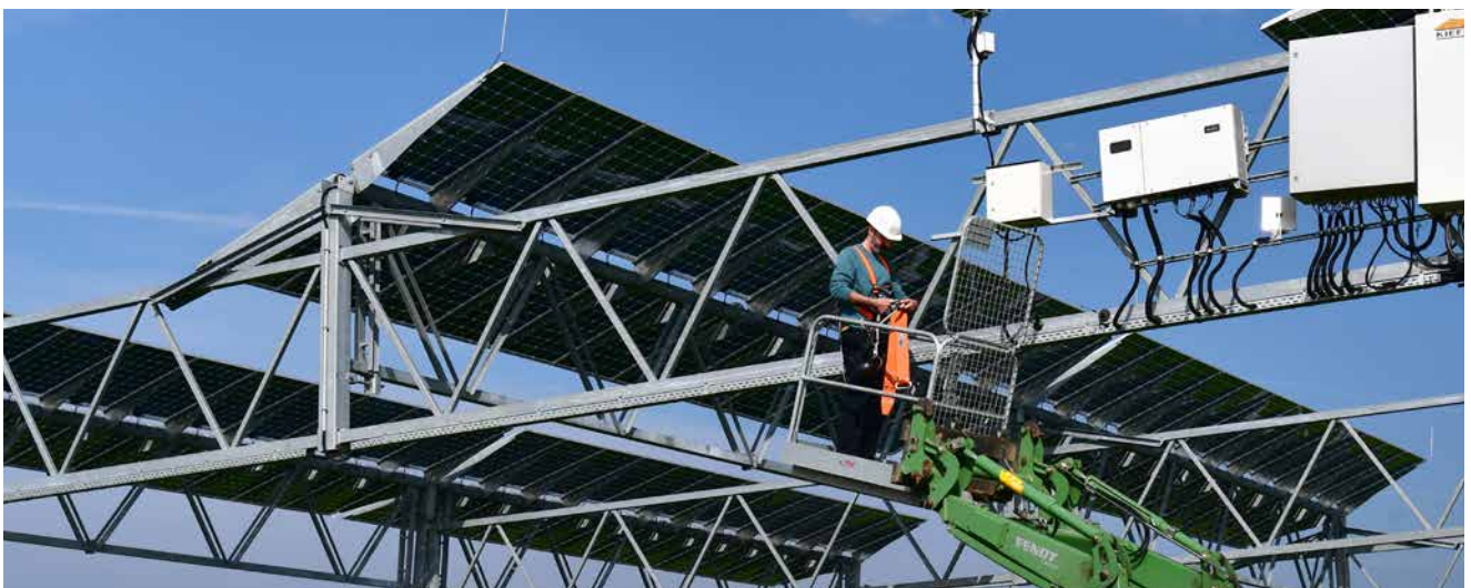
Bild 50: Wartungsarbeiten in Heggelbach. © Fraunhofer ISE
