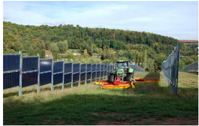
Bild 27: Vertikal errichtete bifaziale Module im Solarpark in Eppelborn-Dirmingen, Saarland mit 2 MW Leistung, errichtet von Next2Sun. © Next2Sun GmbH
