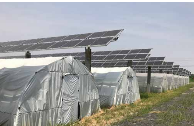
Bild 37: PV-Module über einem Folientunnel. © BayWa r.e.
