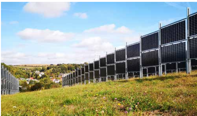
Bild 36: Bifaziale, senkrecht aufgestellte Module von Next2Sun, Donaueschingen. © Next2Sun GmbH
