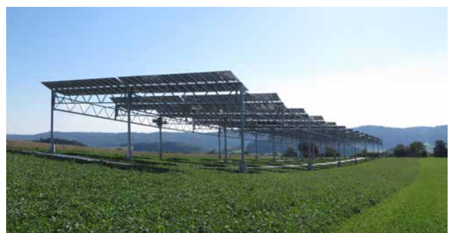
Bild 3: Agri-PV-Forschungsanlage des Fraunhofer ISE am Bodensee.
