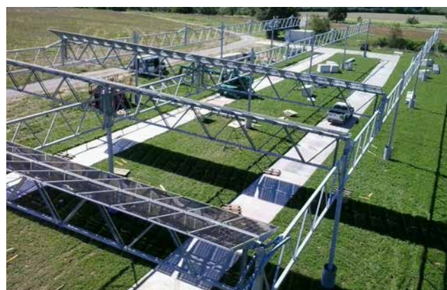
Bild 49: Baustraßen zur Vermeidung von Bodenverdichtung.
