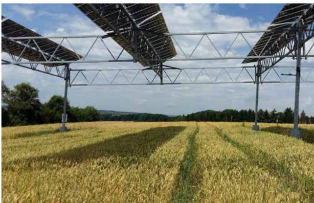
Bild 45: Die Schattenstreifen der Solarmodule wandern mit dem Sonnenstand. © Universität Hohenheim
