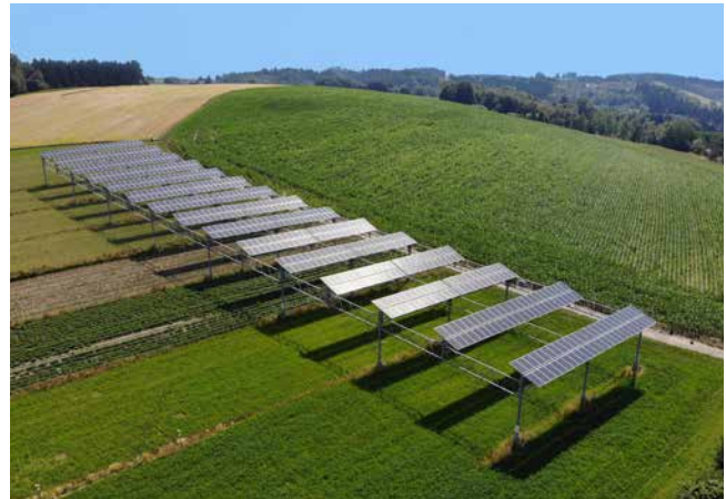
Bild 47: Agri-PV-Anlage in Heggelbach mit einer Leistung von 194 kW p . © BayWa r.e.
