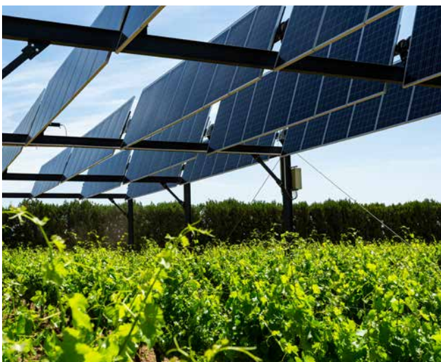
Bild 42: Einachsiges Trackersystem einer Demonstrationsanlage in Frankreich. © Sun'Agri
